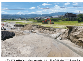
①平成29年の九州北部豪雨被害から復旧した護岸が再度崩壊
